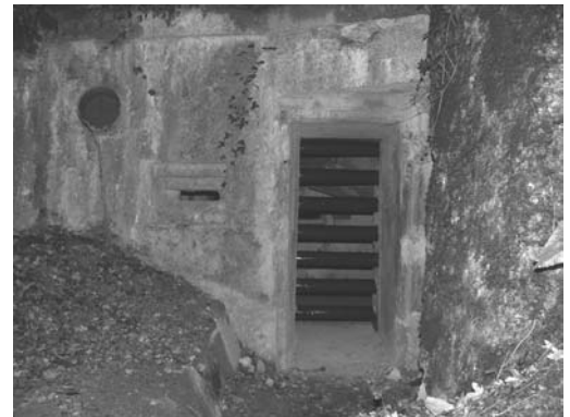
Fermeture de la petite entrée avec des tubes en acier
