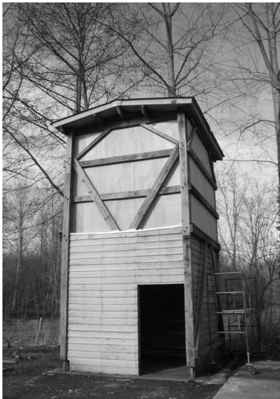
Fig. 1 – Scierie de la Garette, silo en reconstruction
